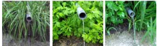
図-2 排水パイプ設置後の効果確認事例
