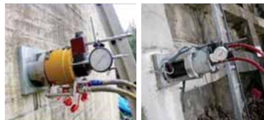
図-3 軽量小型ジャッキを用いたアンカー荷重試験
