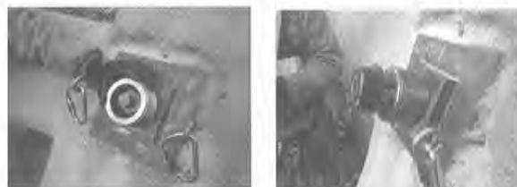
a) インナーカップラーの設置 b) くさびの設置
