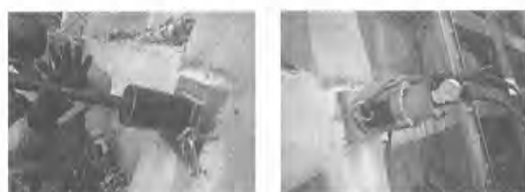
c) アウターカップラーの設置 d) SAAM ジャッキの設置
