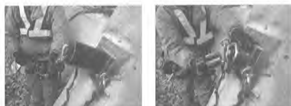
e) レンチによるトルク作用 f) くさびの解除
