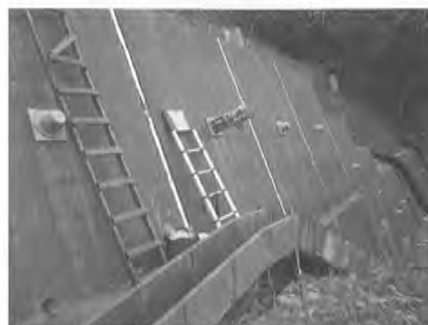
写真-4 SAAMジャッキによるリフトオフ試験状況
