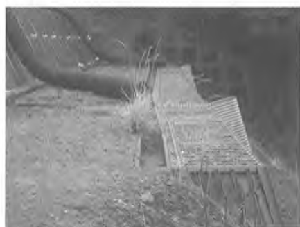
c) かご枠工の押出し
