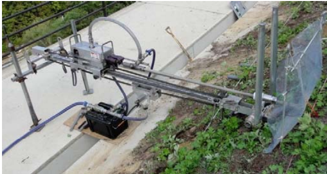
写真-1 機資材設置状況
