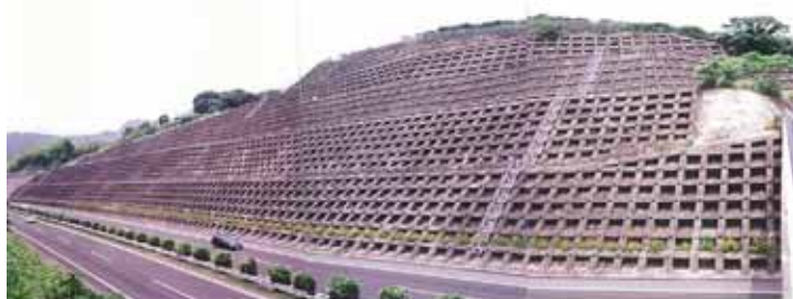
写真-1 当該のり面の全景
