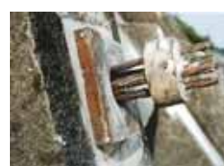
【コンクリートキャップ撤去】
