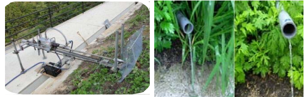
写真-1 工法状況と施工後の排水状況
