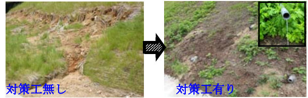
写真-3 抑制工対策工有りと無しのり面状況
