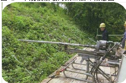
写真-2 対策工法の施工状況
