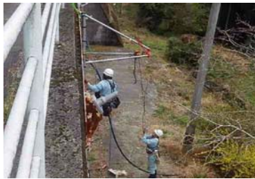
写真4. アンカー抜き取り調査状況
