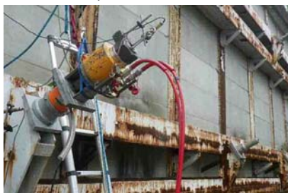
写真7. アンカー耐力確認及び後付け荷重計設置状況
